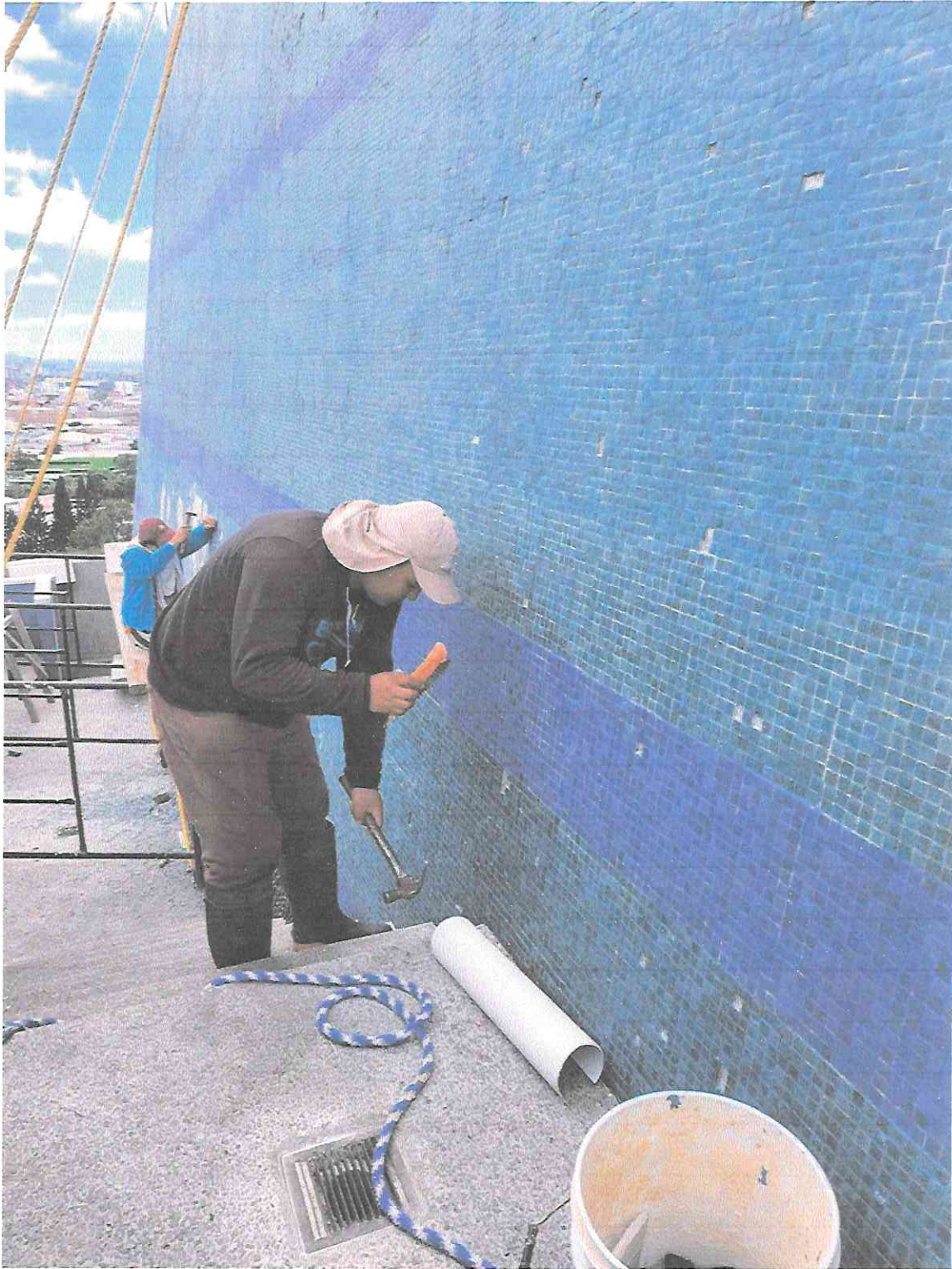
Limpieza y desinfección de teselas de color azul y verde en segmento A1 de fachada Oriente.
